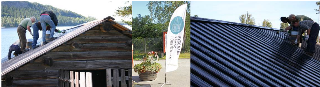
Tjärstrykning av tak under Byggnadsvårdsläget 2013, som hölls i samarbete med Svenska Byggnadsvårdsföreningen.
