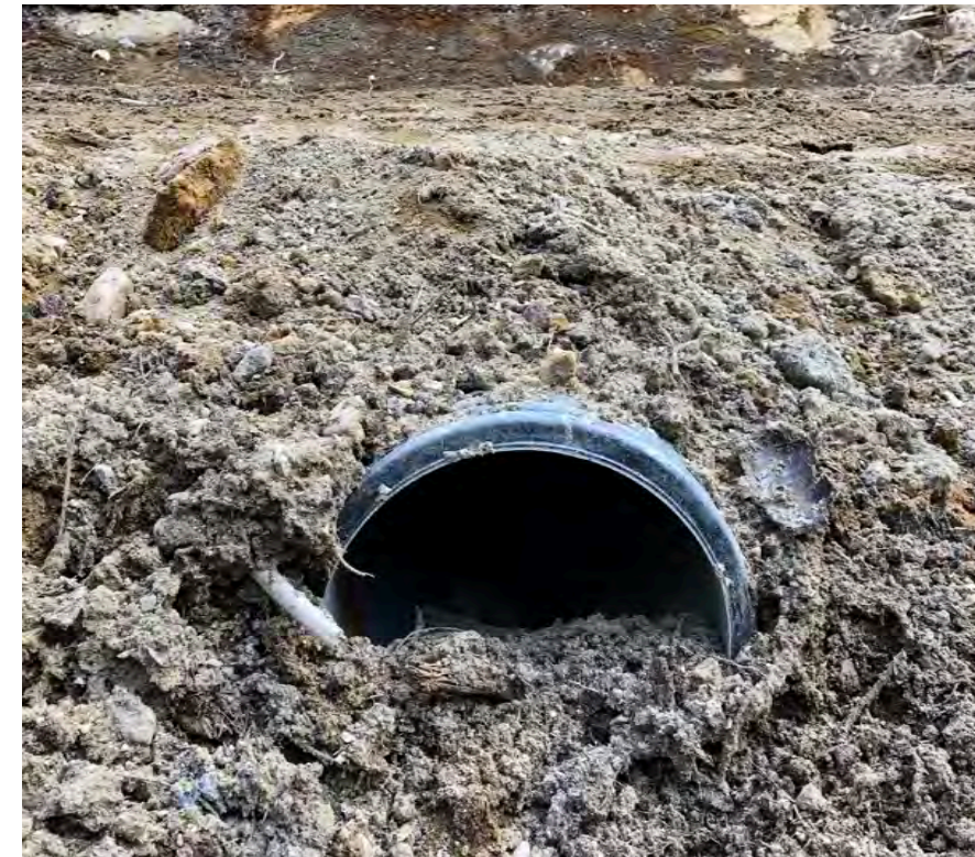
Figur 26. Vägtrummor är oerhört viktiga. Både vad gäller dimensionering, antal och placering. Tilltäppta eller trasiga rör kan få enorma konsekvenser för de områden dit vattnet tar vägen. Detta är ett exempel på dåligt utfört arbete vid läggning av trumman. Bild: Martin Bråthen, Skogkurs.
