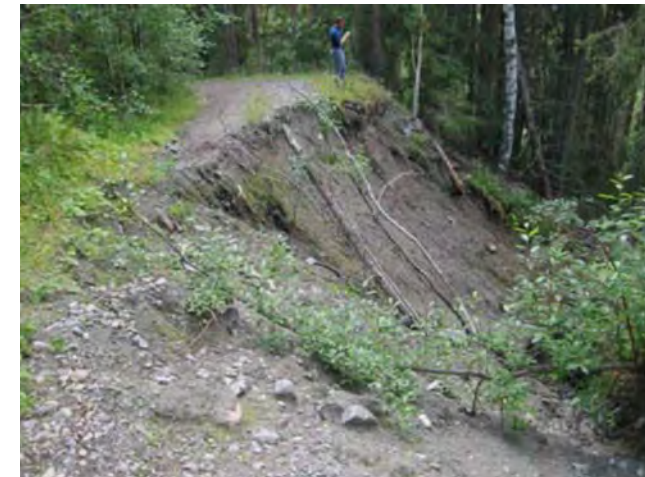
Figur 13. En skogsbilväg som har rasat ut. Foto: Frode Sandersen
