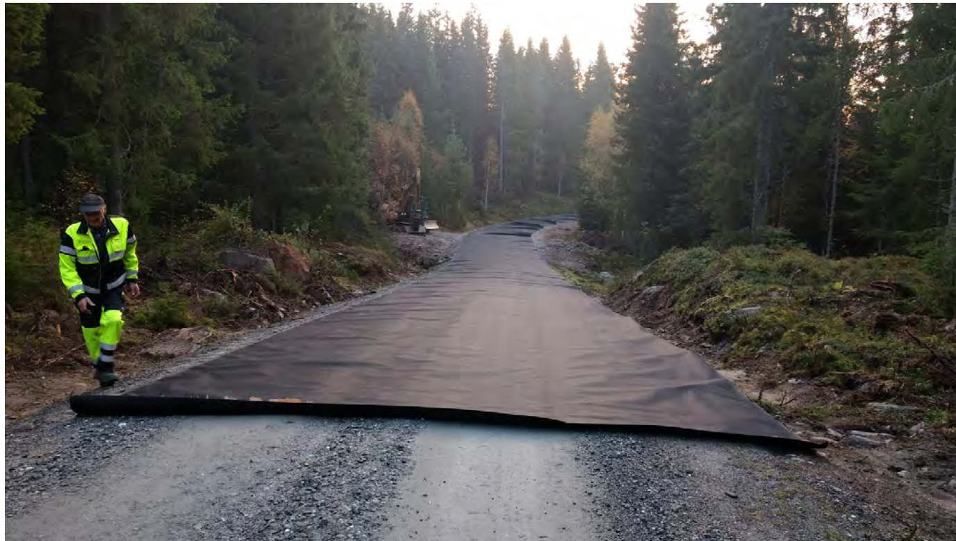
Figur 25. Fiberduk används för att separera befintliga massor med ditkörda massor. Blandning av massorna minskar bärigheten. Bild: Romeriks allmenningene v/ Johannes Enersen.
