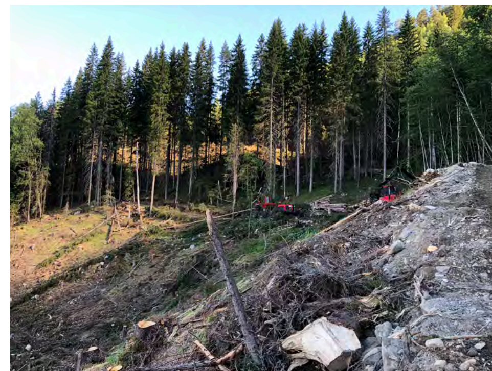
Figur 11. Drift i brant terräng. Här har en grävmaskin iordningställt driftvägar för att ge skogsmaskinerna tillgång till virket på ett säkert sätt. Foto: Martin Bråthen, Skogkurs.
