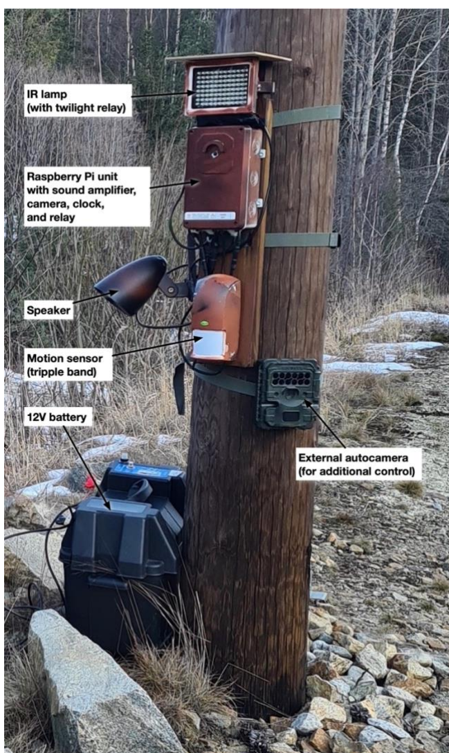
Figur 9. Ny MASS3 enhet monterad på en kraftledningsstolpe bredvid järnvägen. Batteriet laddas med solcell (inte på bild).
