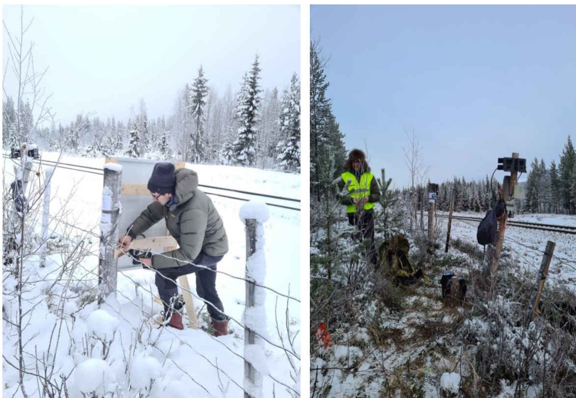
Figur 8. Montering av MASS enheter vid Rørosbanen.
